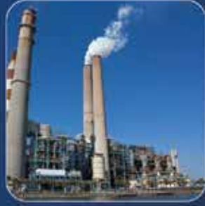
Enerji Üretim ve Dağıtım Sistemleri
